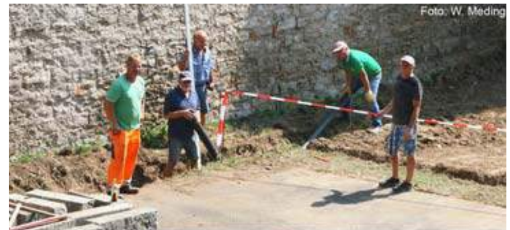
Männer des Ochsenfurter FV stehen dem Bauhof „Geräte bei Fuß“ und helfen bei der Sanierung des Festplatzes im Stadtgraben für anstehende Festivitäten, wie das jährlich stattfindende internationale Weinfest.
